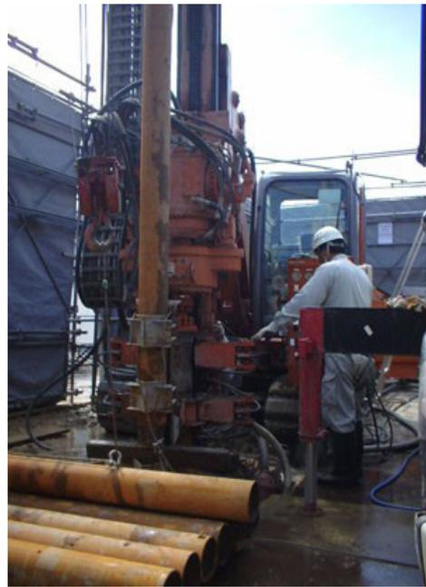
図2 鋼管による掘削作業の様子
